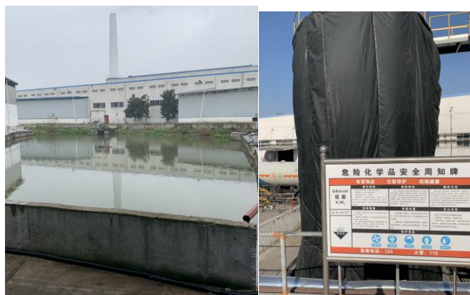
初期雨水收集池
